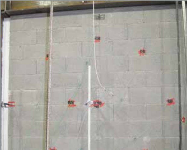
Bild 5.1: Vor einem Brandraum druckdicht eingebaute Prüfwand mit zur Messung ein-/ angebaute Thermoelementen
