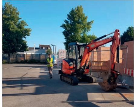
Nicht nur falsch geparkte Fahrzeuge, sondern auch die Bepflanzung am Entladeort können zum Hindernis werden. So blockieren hier Hecken und Bäume den Weg zur Baustelle. Zufahrt sowie Kranentladung sind in solchen Fällen nicht möglich, da eine Beschädigung des Fahrzeugs durch Äste nicht auszuschließen ist.
