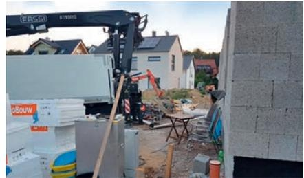
Auf dieser Baustelle sollen Leichtbetonprodukte nach Absprache mit dem Disponenten in die erste Etage gesetzt werden – sowohl neu angelieferte als auch jene, die dort bereits stehen. Allerdings sind die Umstände auf der Baustelle eher chaotisch: Steine, Paletten und weitere Baumaterialien versperren den Weg. Eine korrekte Entladung ist nicht möglich, bevor die Hindernisse durch das zuständige Baustellenpersonal aus dem Weg geräumt wurden.
