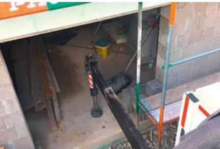
Im Gegensatz zum vorherigen Beispiel ist der Abstand hier zu gering: Die Stützen des Krans stehen auf der Bodenplatte des Neubaus. Durch diese Belastung können Schäden am Bauwerk entstehen. Daher dürfen die Kranstützen so nicht ausgefahren werden.
