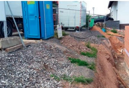
In diesem Beispiel ist etwa der Abstand zwischen Kran und Baustelle zu groß. Aufgrund der ausgehobenen Baugrube sowie weiterer Einschränkungen – wie etwa Bauzaun und Container – ist das Abladen der Leichtbetonpakete hier nicht möglich.
