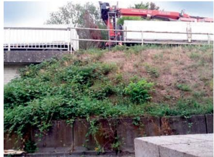
Auch das Parken auf abschüssigem Gelände birgt Risiken: Ist das Gefälle zu groß, wird einerseits die Ladungssicherheit beeinträchtigt. Auf der anderen Seite wird der Entladeprozess erschwert. So besteht bei diesem Beispiel die Gefahr, dass beim Ausfahren der Stützen die Bremsen außer Kraft gesetzt werden könnten. Zudem müsste der Kran quasi bergauf bewegt werden, was die Entladung zusätzlich erschwert.
