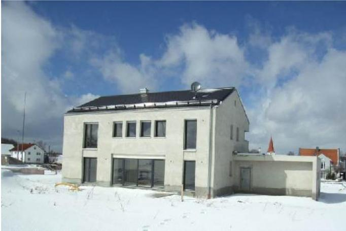
*Bieten Kälte und Nässe die Stirn: Häuser aus Leichtbeton überzeugen aufgrund ihrer mineralischen Bestandteile mit hervorragender Wärmedämmung und Feuchteregulierung. Dabei kann auf eine kostspielige und ausführungsempfindliche Außendämmung komplett verzichtet werden.*
